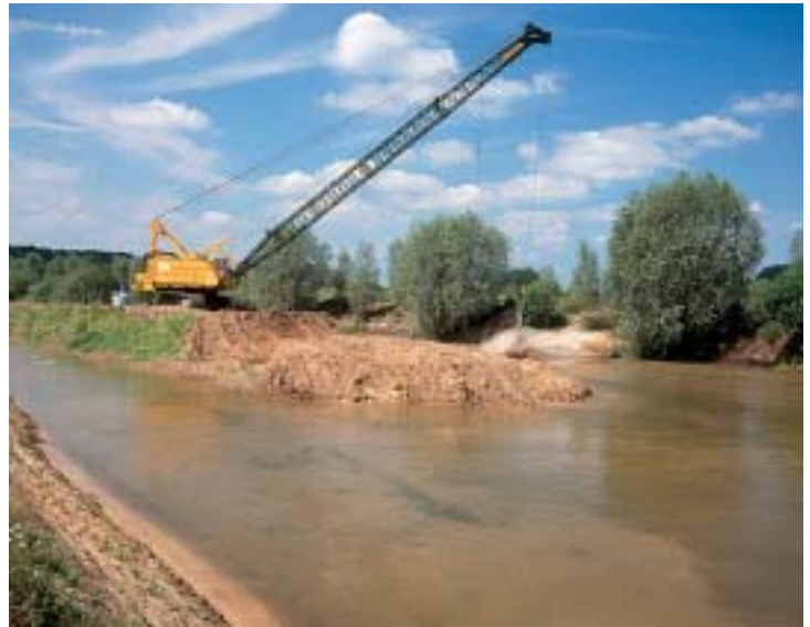
Abbildung 6: Bagger bei der Verbreiterung der Lippe in der Klostermensch 1997 im Rahmen der Renaturierung von Fluss und Aue: Das hinter dem Bagger liegende Ufer blieb bis auf die Entfernung der Schüttsteine unverändert. Foto: M. Bunzel-Driike
