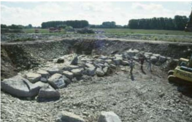
*Die Sohlrampe wurde im Trockenen gebaut. Ihre ausgeklügelte Konstruktion schafft zwischen den Steinen Ruheräume für aufsteigende Wassertiere.*
